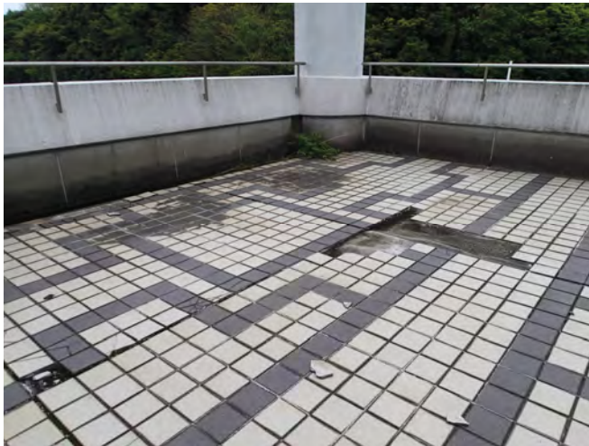
職員室上部（テラス）状況
