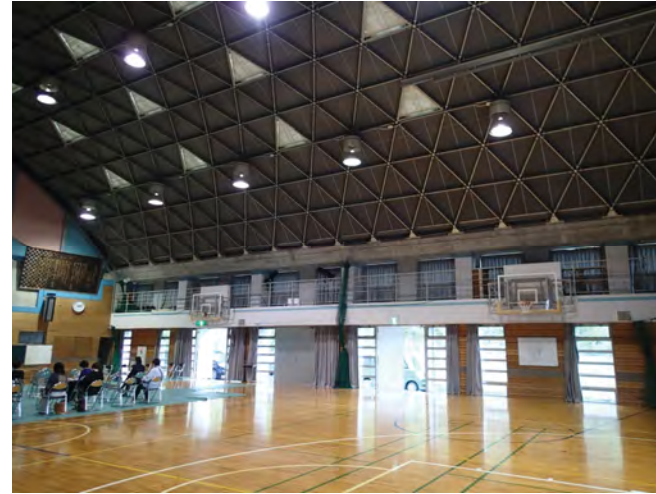
体育館内装状況
