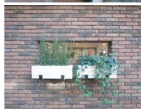
通りに面する部分を緑化した店舗の整備例
