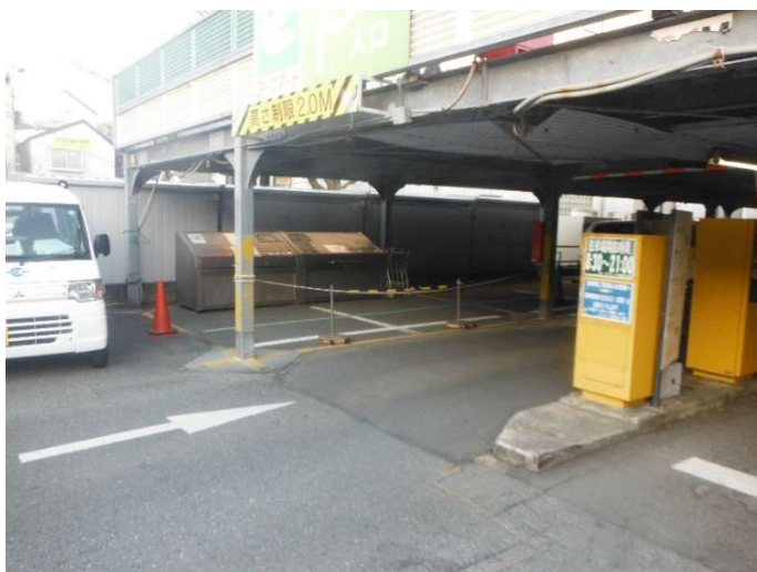
↑ 立体駐車場正面左側
