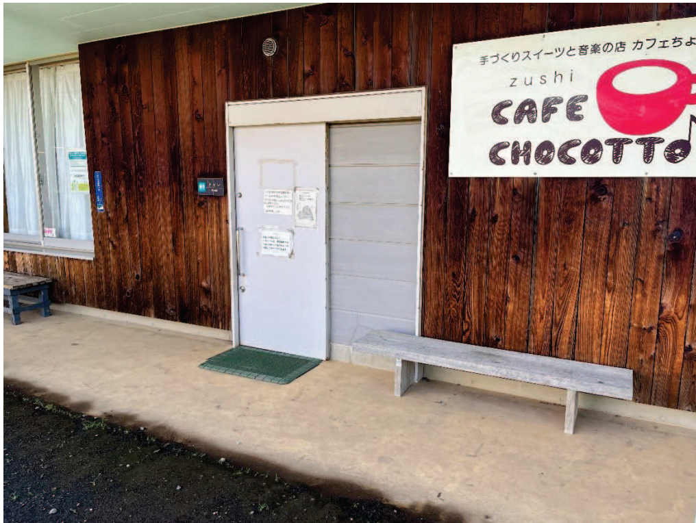
現況写真 外観
