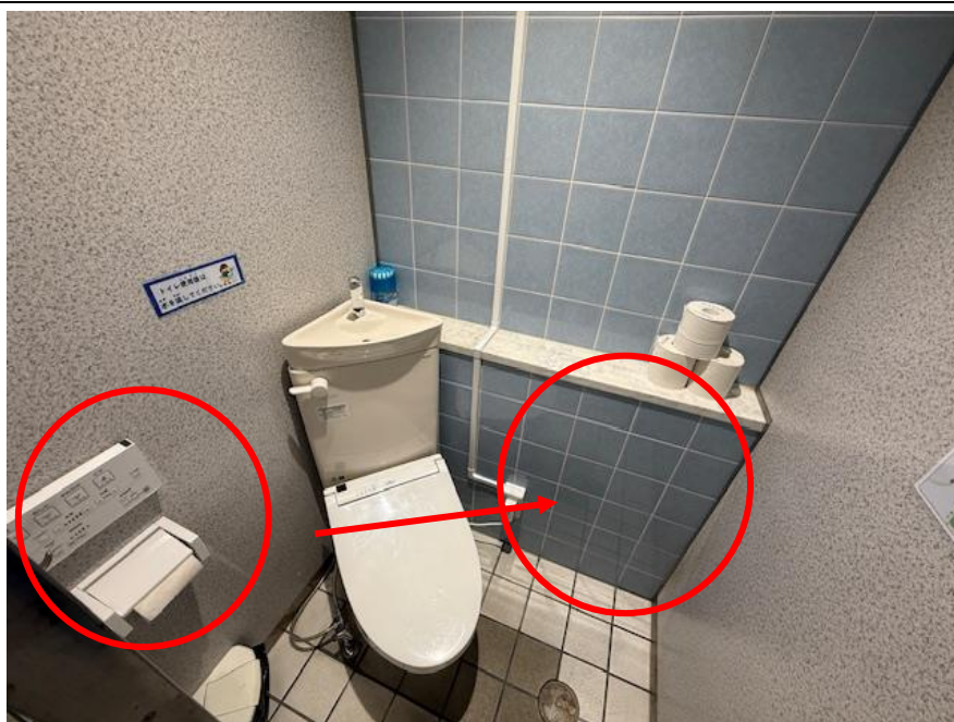
⑬ リモコン及びトイレホルダー の移設
