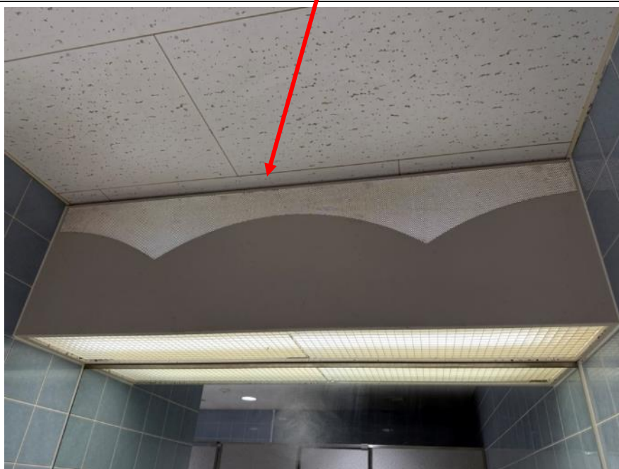
⑨ 塗装する鉄部の参考例（寄り）
