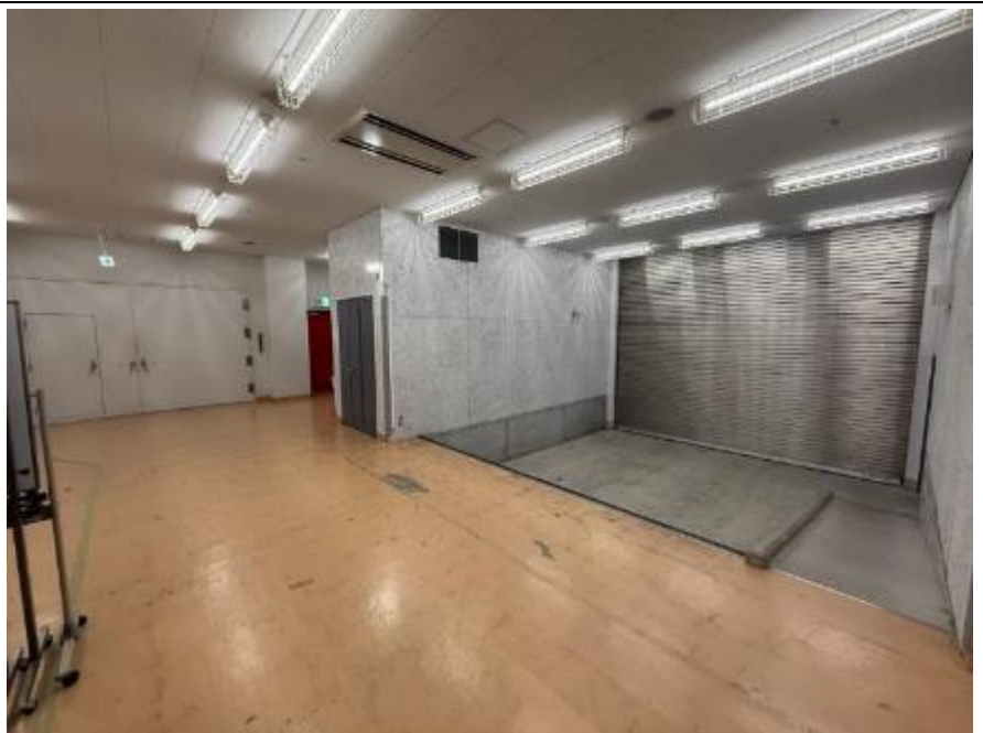
② 搬入口シャッター内部 エレベーターとスロープ撮影
