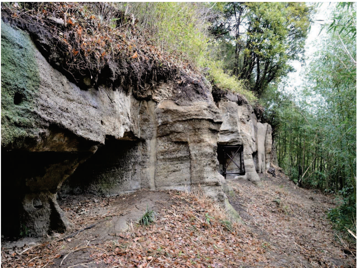
④ 4 トレンチ設定予定地（南から）
