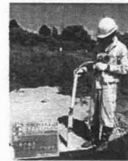
写真-2 水中ポンプの挿入状況
