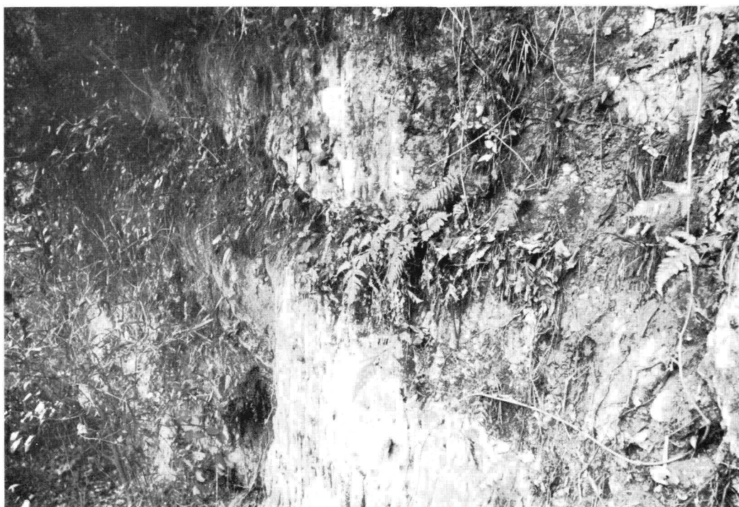
(上・下) おさる畠切岸群の崖面状況
