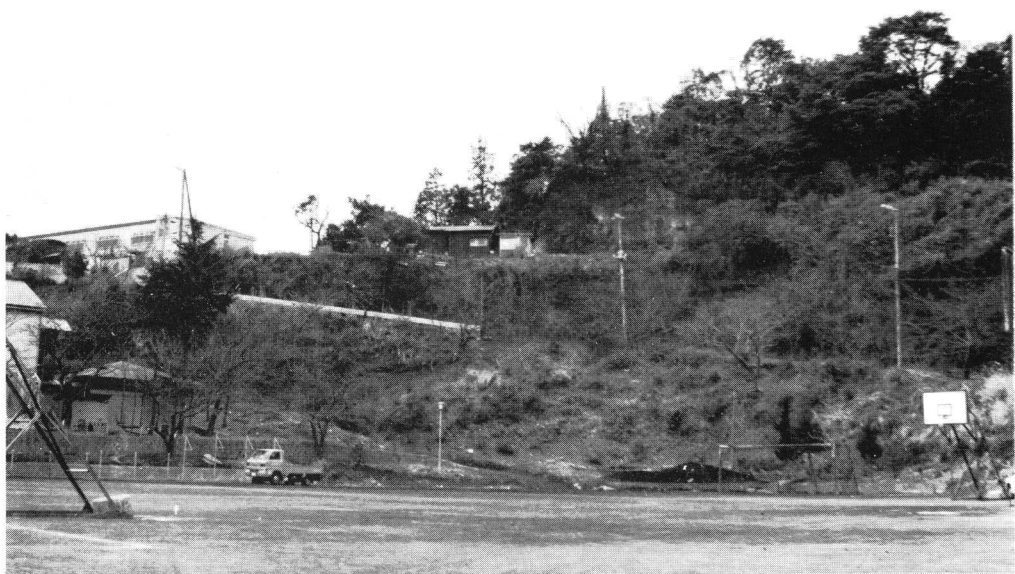
鎌倉側 光明寺裏手の遺構群遠景
