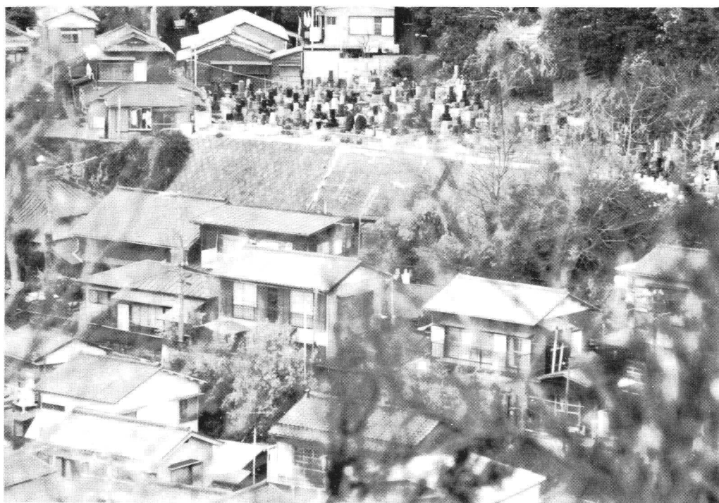
小坪寺付近の平場と切岸の現状
