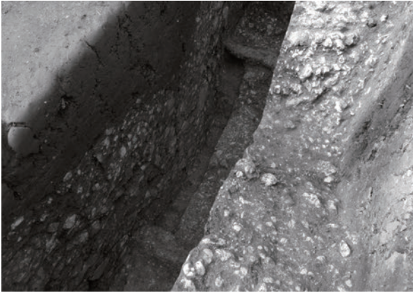
1 17トレンチ 粘土・炭検出状況2 (東から)
