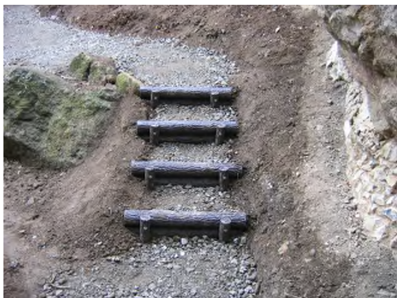
写真 4-7-26 階段設置状況 (4 段)
