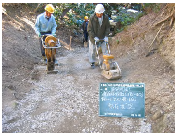
写真4-7-21 砕石敷き均し転圧状況
