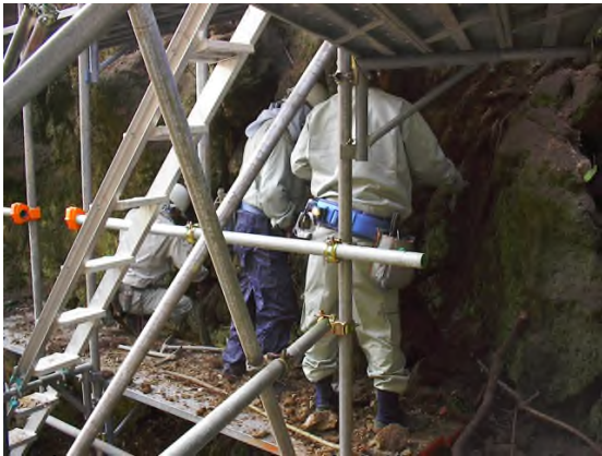
写真 4-7-9 浮石除去状況 (サイトB)
