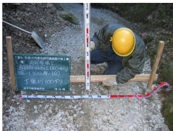
写真4-7-22 厚さ確認状況 (丁張りφ100mm下がり)
