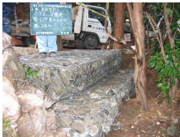
写真4-7-20 ふとんかご設置状況
