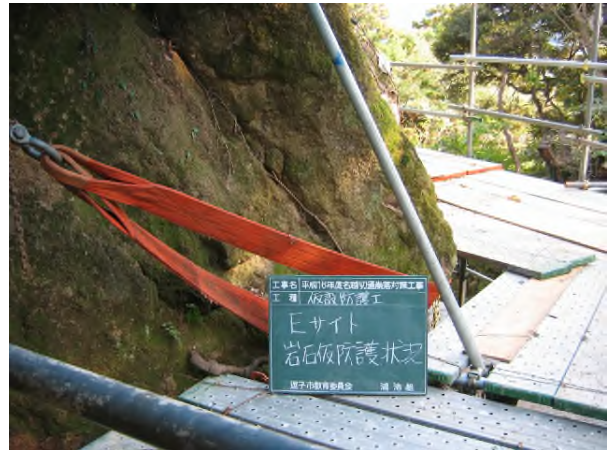
写真4-7-6 サイトE仮防護状況 (西面より)
