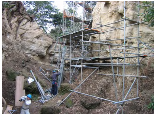
写真4-7-4 サイトE・F足場解体状況
