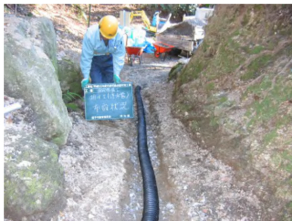
写真4-7-18 透水管設置状況
