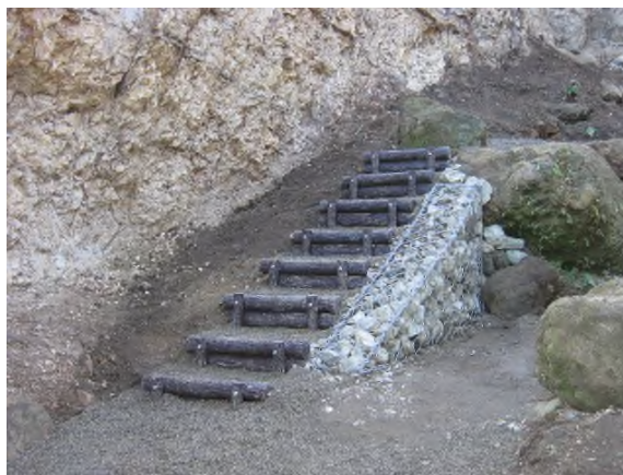
写真 4-7-27 階段設置状況 (8 段)
