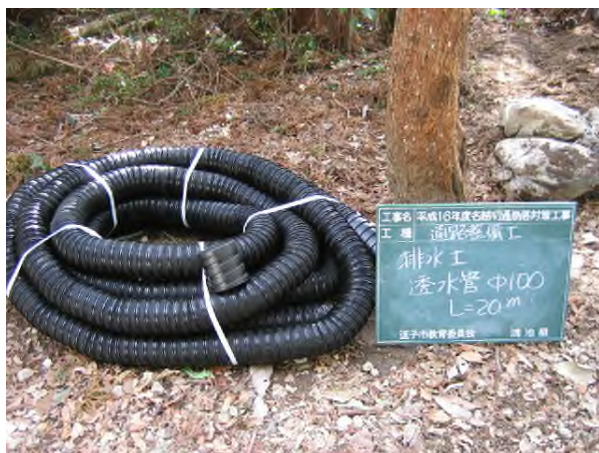
写真4-7-17 透水管(径 100mm、L=20m)
