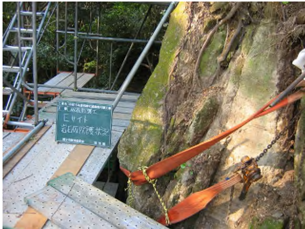
写真4-7-5 サイトE仮防護状況 (東面より)
