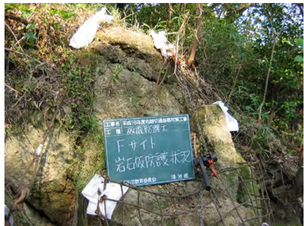
写真4-7-8 サイトF仮防護状況 (南面より)
