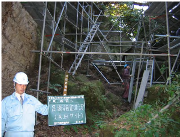
写真4-7-1 サイトA・B足場組立状況
