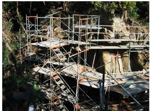
写真4-7-2 サイトE・F足場組立状況
