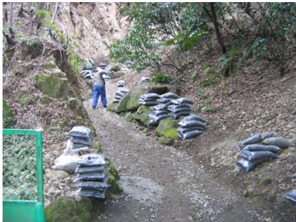
写真 4-7-23 敷き砂利敷き均し状況
