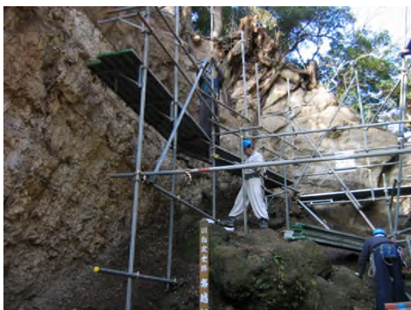
写真4-7-3 サイトA・B足場解体状況
