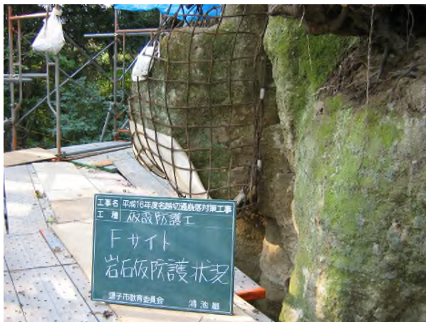
写真4-7-7 サイトF仮防護状況 (東面より)
