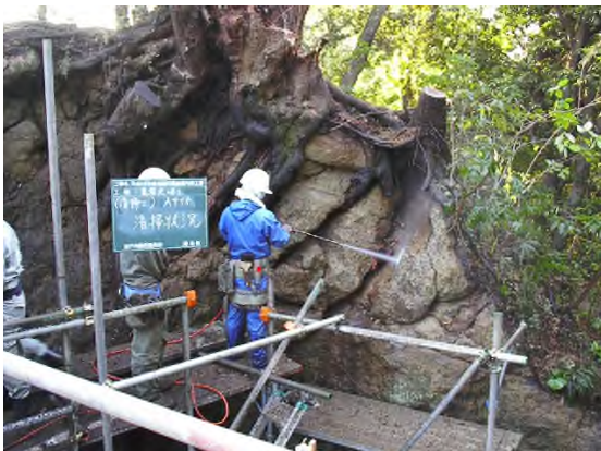
写真 4-7-11 洗浄状況 (サイトB)
