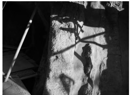
写真 4-4-26 グラウト注入完了状況
