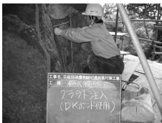
写真 4-4-19 グラウト注入状況
