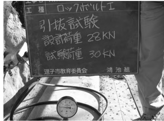
写真4-4-11 試験荷重確認状況
