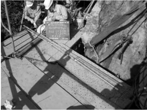
写真4-4-8 ロックボルト検尺状況
