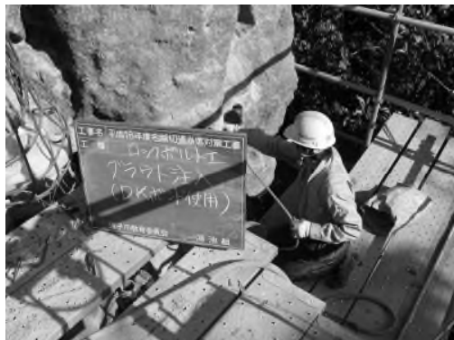
写真4-4-7 グラウト注入状況
