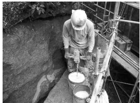
写真 4 - 4 - 3 4 D K モルタル練り混ぜ状況
