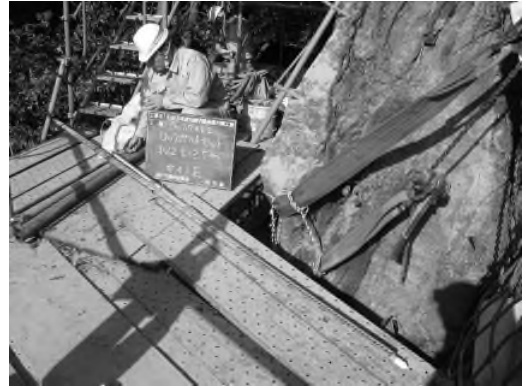
写真 4-4-24 ロックボルト検尺状況 (径 19mm、 L=1.25\text{m} )
