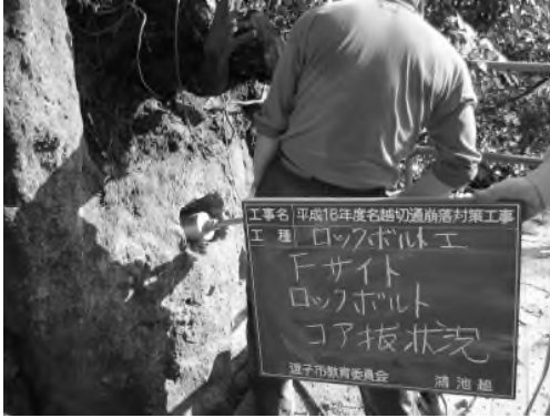
写真4-4-2 コア抜き状況（サイトF）
