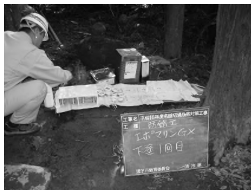
写真 4-4-22 防錆塗料下塗り状況
