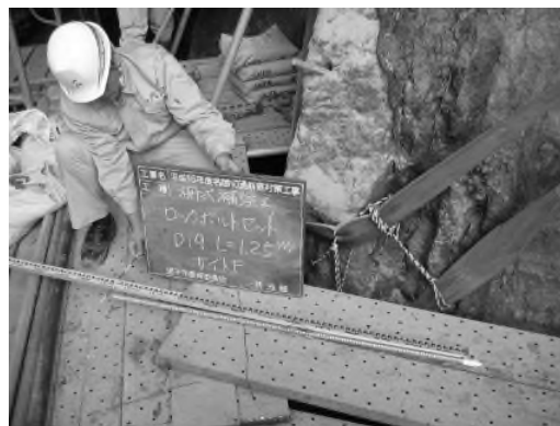
写真 4-4-18 ロックボルト検尺状況 (径 19mm、L=1.25m)
