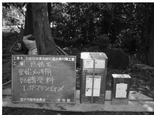
写真 4-4-21 亜鉛めっき用防錆塗料 エポマリンGX：関西ペイント(株)
