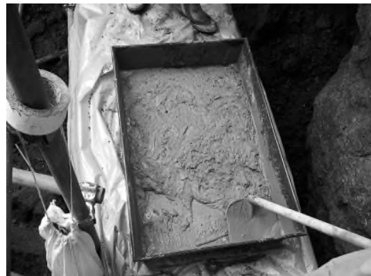
写真 4 - 4 - 3 0 DKモルタル練り混ぜ状況
