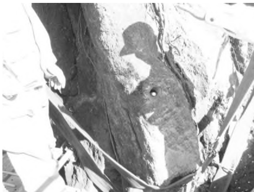
写真 4-4-25 ロックボルト挿入状況
