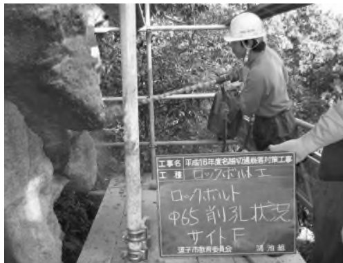
写真4-4-4 削孔状況（孔径 65mm）
