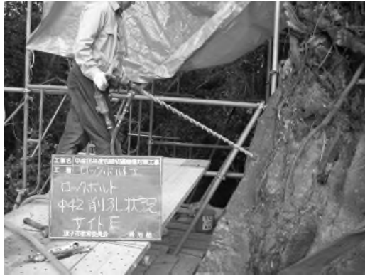
写真 4-4-23 削孔状況
