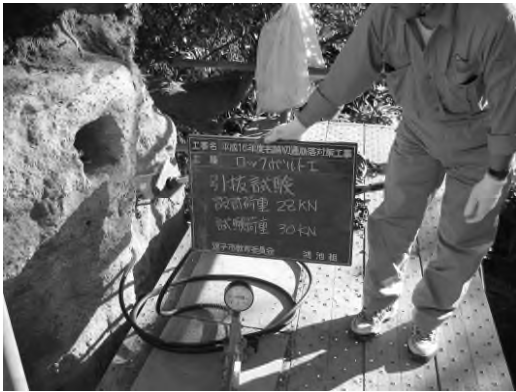
写真4-4-10 引抜き試験状況
