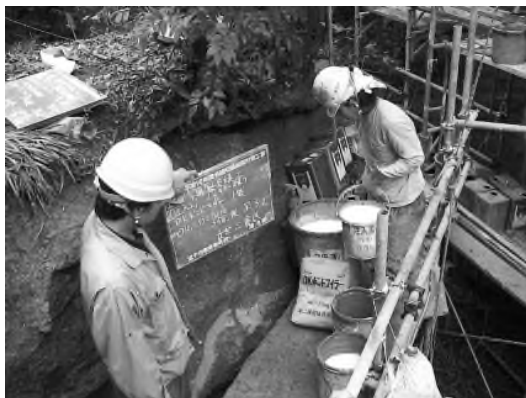
写真 4 - 4 - 3 3 材料配合状況
