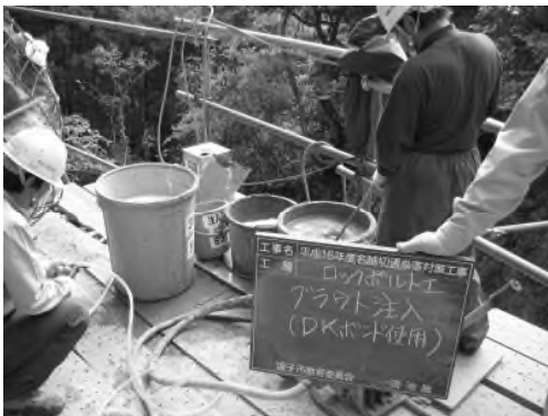
写真4-4-6 グラウト注入材練り混ぜ状況
