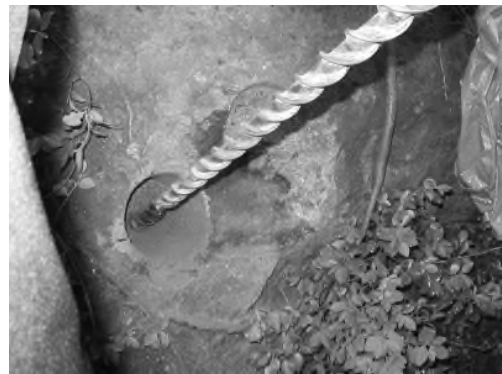
写真4-4-5 削孔状況近景
