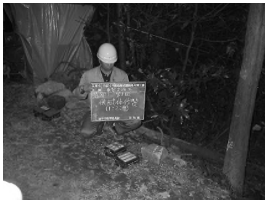
写真 4 - 4 - 4 2 現場供試体作成状況(注入モルタル)
