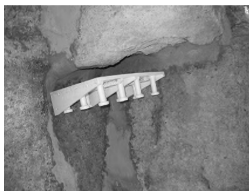
写真 4-4-20 埋込み金物設置状況
