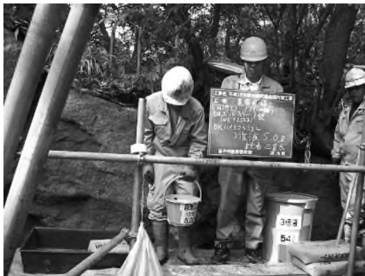
写真 4 - 4 - 2 9 材料配合状況
