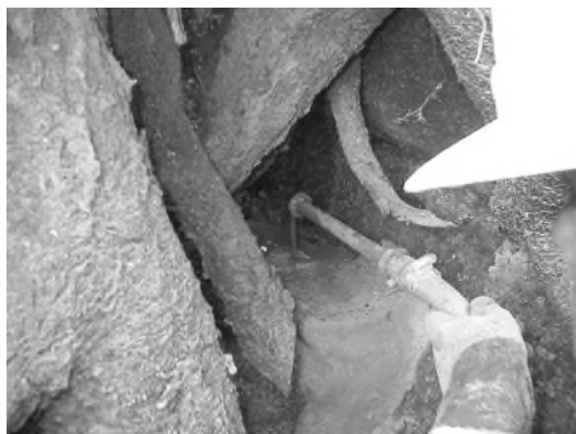
写真 4-4-35 注入工施工状況（サイトB） 写真 4-4-36 注入工施工近景（サイトB）
