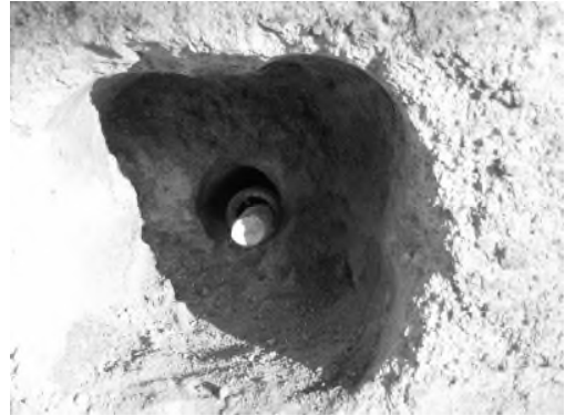
写真4-4-9 挿入完了状況
