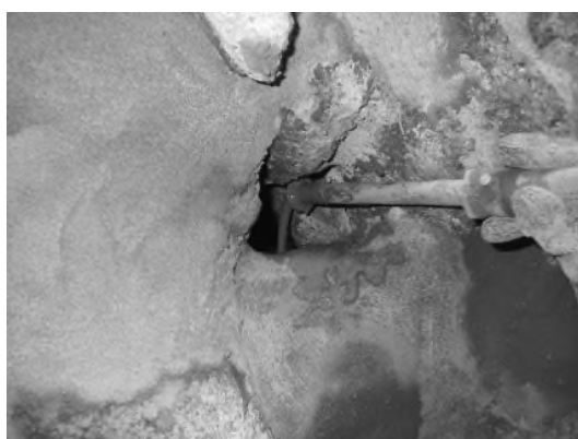
写真 4-4-37 注入工施工状況（サイトF） 写真 4-4-38 注入工施工近景（サイトF）
