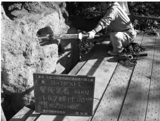
写真4-4-12 緊張定着状況
