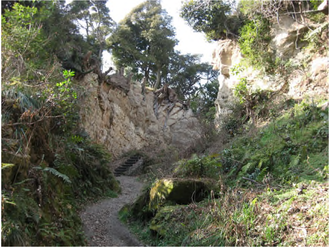
切通の現況（東より望む） 平成 19 年 1 月撮影
