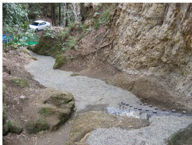
竣工写真 切通通路（敷き砂利）
