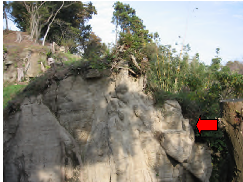
サイトFで確認されたやぐらの痕跡（南より望む）
