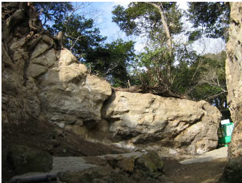
竣工写真 サイトA
