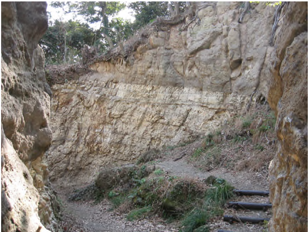
切通の現況（北より望む） 平成 19 年 1 月撮影
