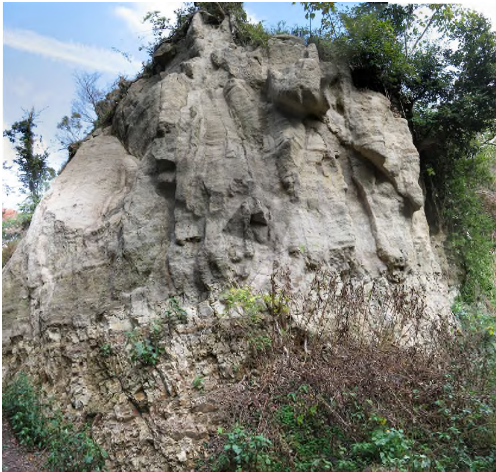
竣工写真 北側崖面全景
