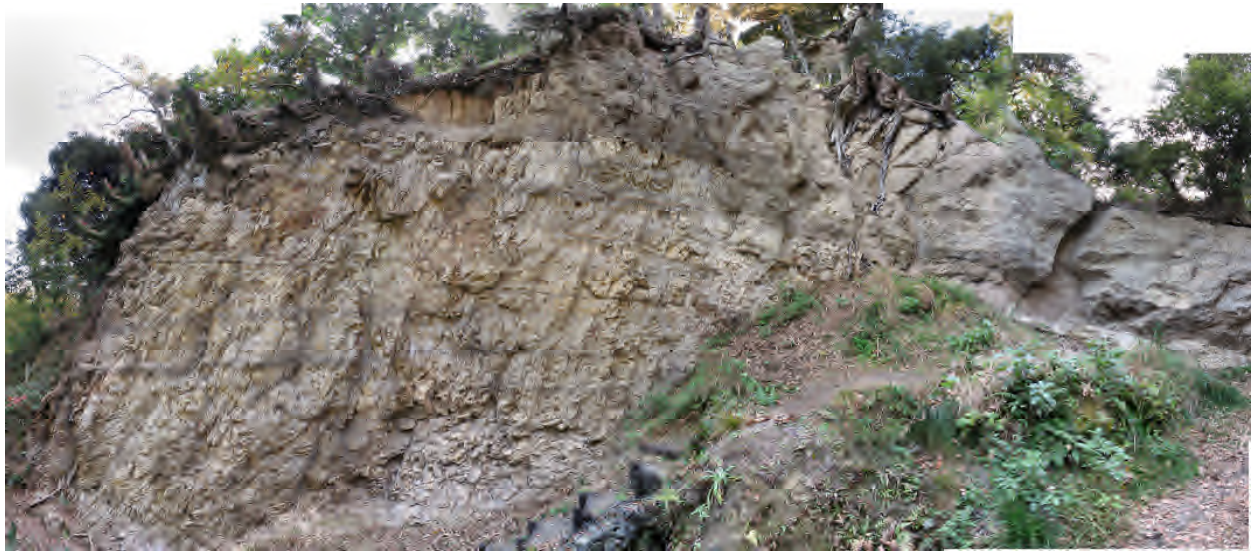
竣工写真 南側崖面全景
