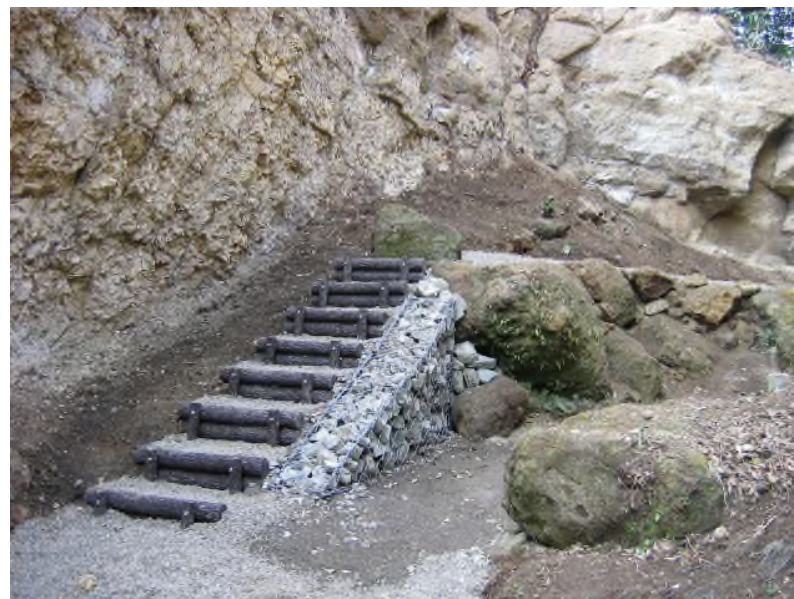
竣工写真 切通通路（階段）
