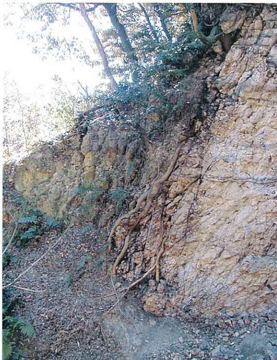
サイトCの樹根による崩落（逗子層泥岩） 樹根周辺は細かく割れ、崩落を継続させている。
