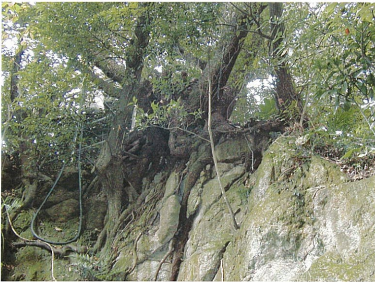
写真 6-3-8 サイトB壁面上部の 山桜の樹根状況
