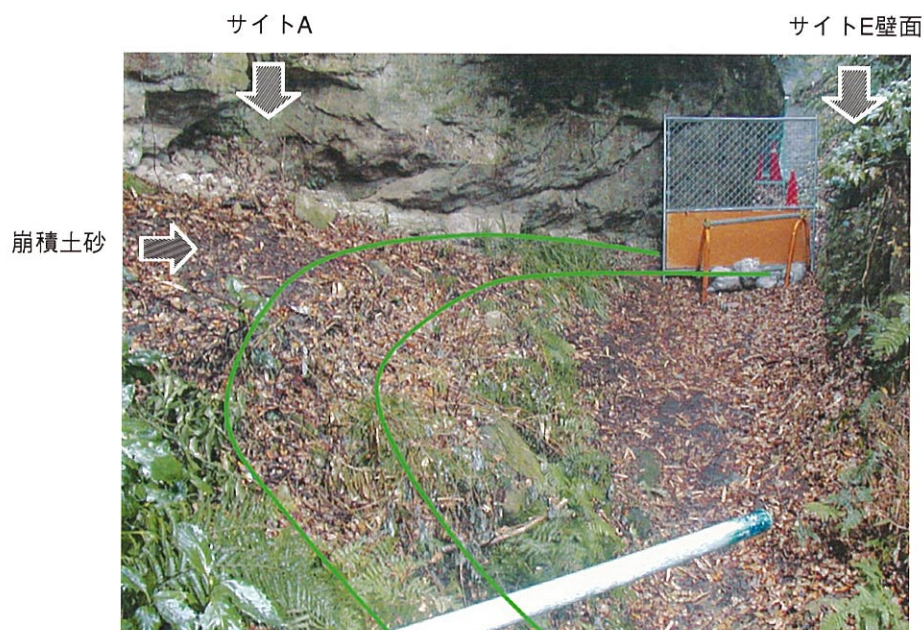
写真6-3-1 サイトA-E区間 ・現通路をシフトし緩衝帯を設ける（2m程度）
