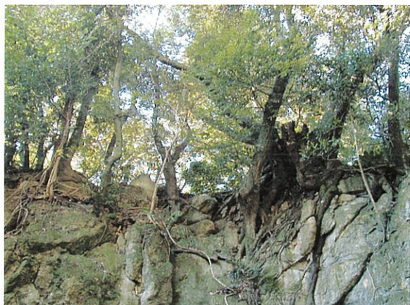
サイトB 東側：池子層砂岩の押し割り樹根が生長している。一部、浮石状となっており、崩落の危険性がある。
