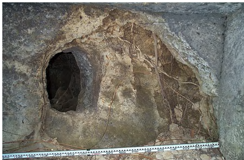
P-5 正面、根 欠損 穴
