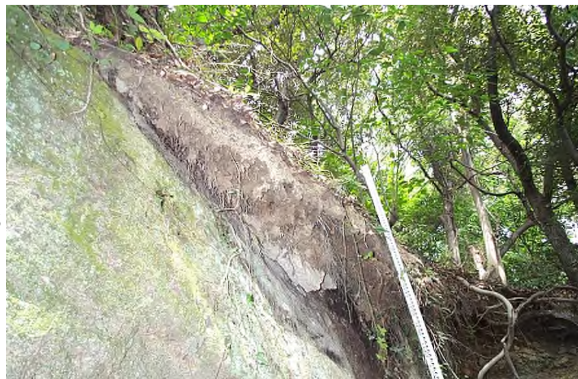
P-8 手前上部 表土
