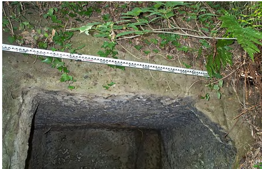
P-2 上、天井 欠損
