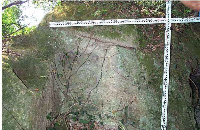
P-4 正面 クラック 天井欠損
