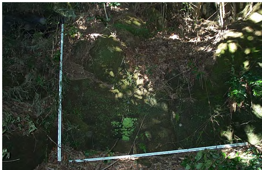
P-3 正面壁 上部欠損
