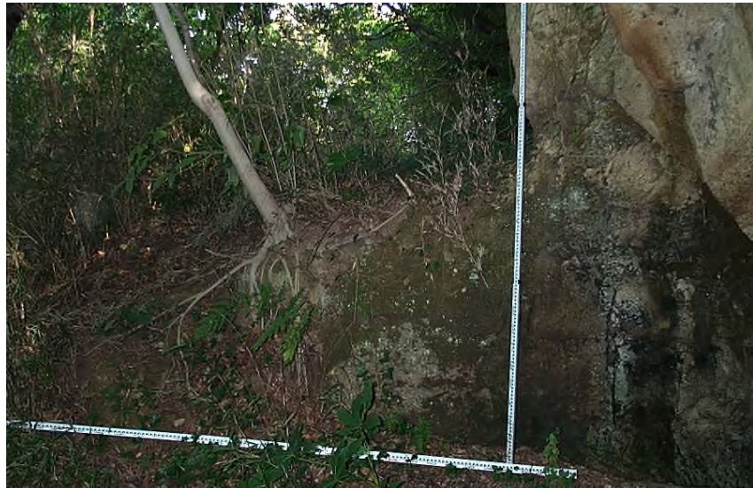
P-2 左壁 クラック 欠損
