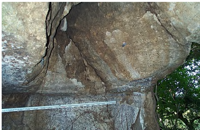
P-5 天井落盤
