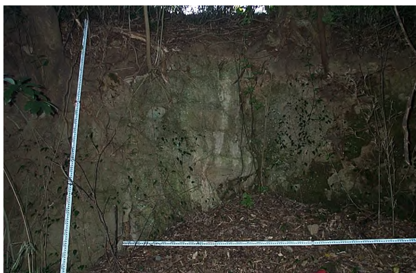
P-3 正面壁 欠損
