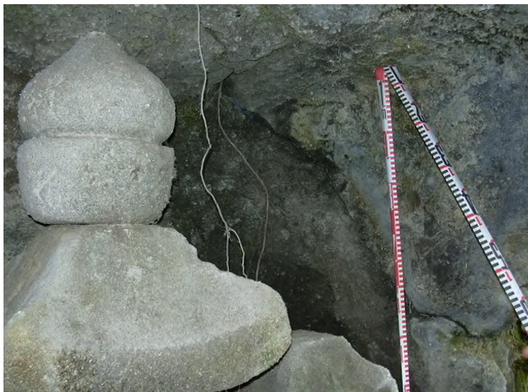
P-3 右壁～ 天井の クラック
