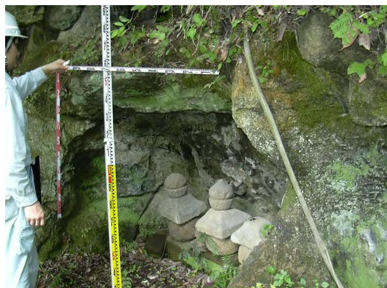
P-3 天井右壁 欠損
