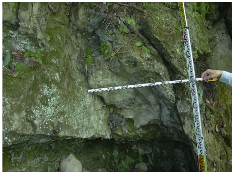
P-5 天井欠損
