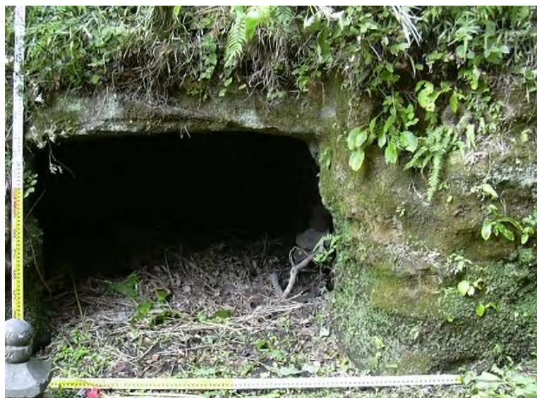
P-4 天井の クラック
