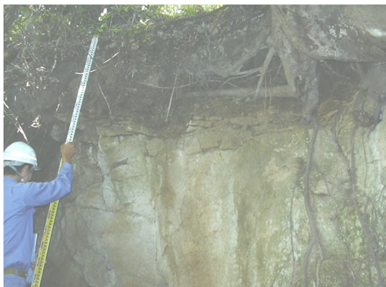
P-5 天井欠損
