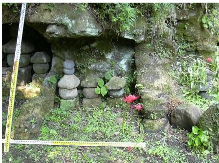
P-4 左右壁、 天井の 欠損
