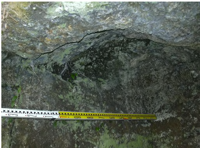
P-5 左壁、 天井 塩類風化
