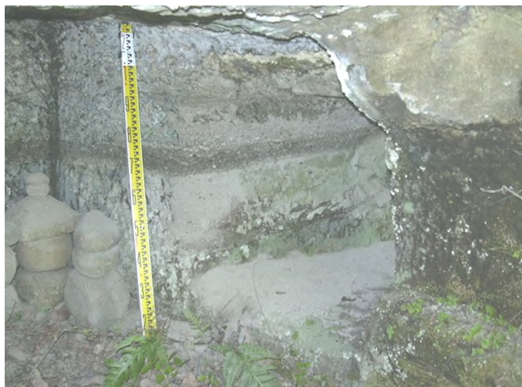
P-5 右壁 一部欠損 通路状
