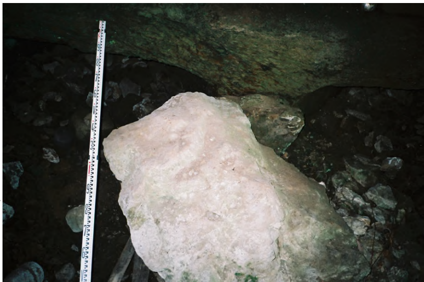
P-5 右壁欠損 と 崩落した岩
