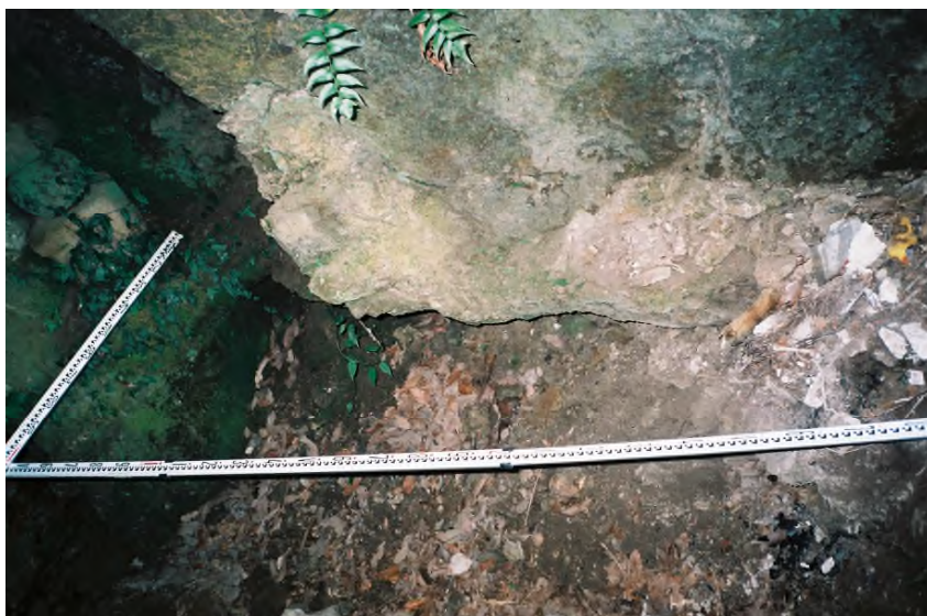
P-3 天井欠損
