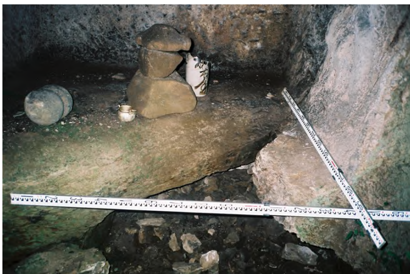
P-4 天井欠損
