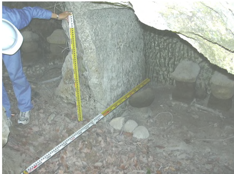
P-4 左壁欠損 天井欠損
