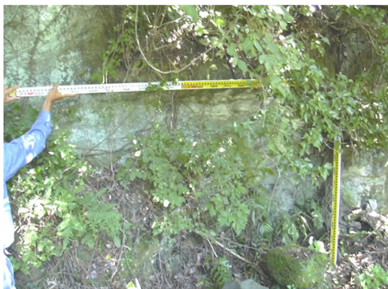
P-4 天井欠損
