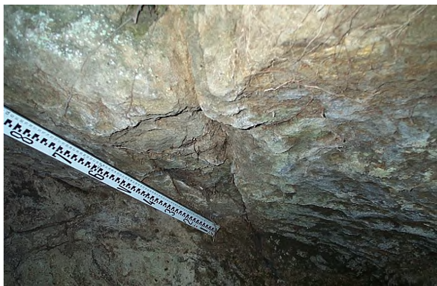
P-3 天井の クラックと 剥離
