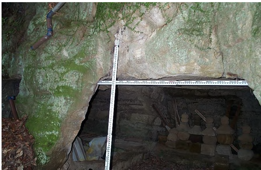
P-3 前部天井 および左 欠損
