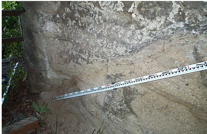
P-2 左壁の クラック
