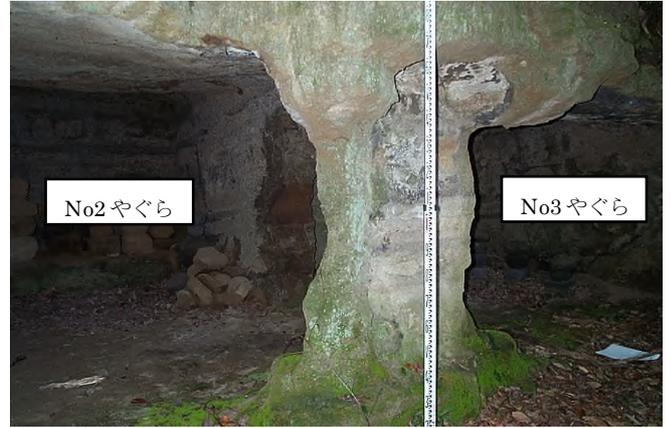
写真 3-2 No2,3 境界、壁が欠損し一続きになっている。
