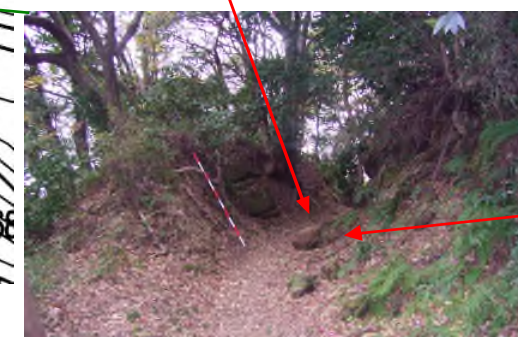
K3-1 第3切通、逗子側入口、東側斜面浮き石多数認められる。また、落下した転石認められる。
