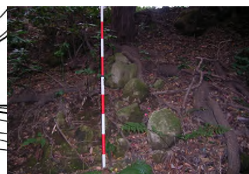
K3-3 東側、池子層凝灰質砂岩の転石、径 40cm 前後、4箇所に認められる。やや不安定。
