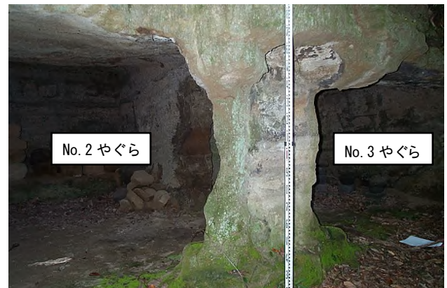
写真 2-2 No. 2, 3 境界、壁が欠損し一続きになっている。
