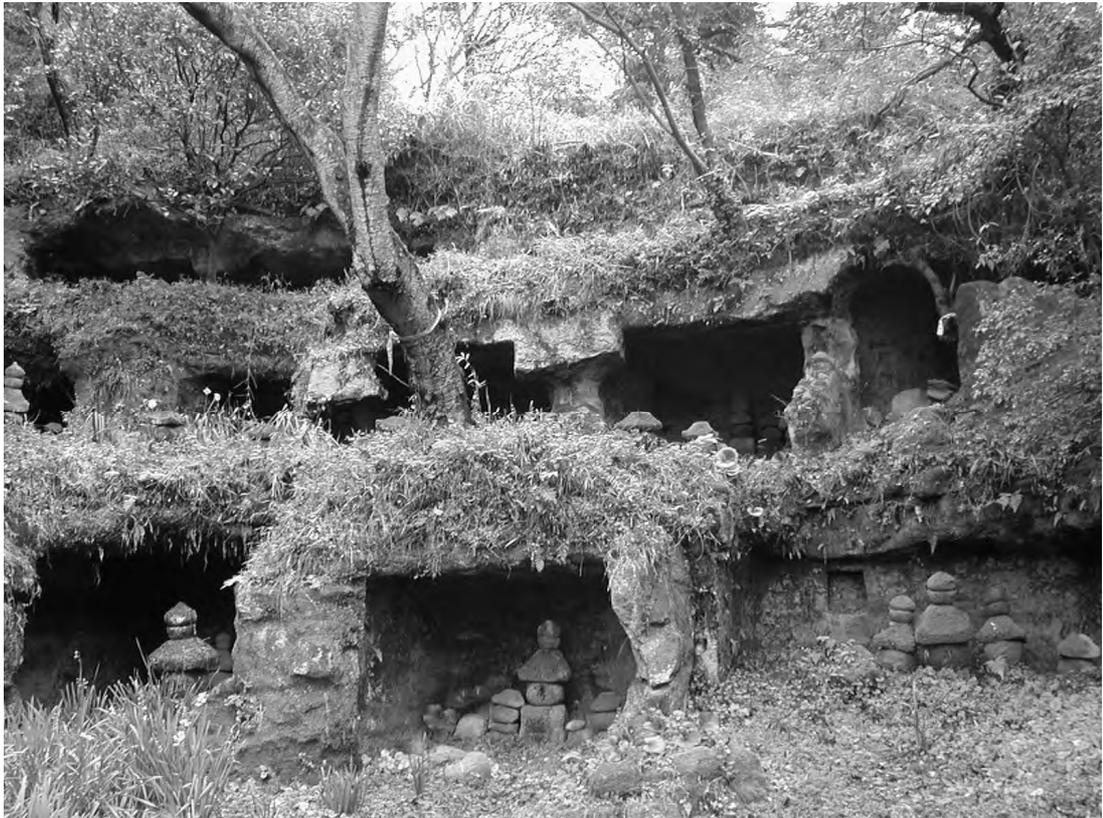
**まんだら堂やぐら群の近景**：岩盤の風化による経年劣化に加え、自生した樹木が成育し、木根が岩盤の割れ目を押し広げている。やぐらの側面や天井の崩壊が進んで一部浮石化し、やぐらの内部から運び出された石塔が雨ざらしで点在している。
