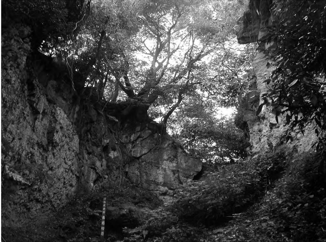
**整備前の第1切通**：逗子側から鎌倉側を望む。壁面の岩盤は、割れ目に木根が侵入して浮石化するとともに、風化が進行している。
