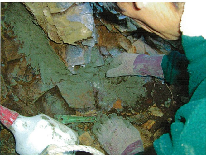
写真 5-5-5 目地工の施工状況
