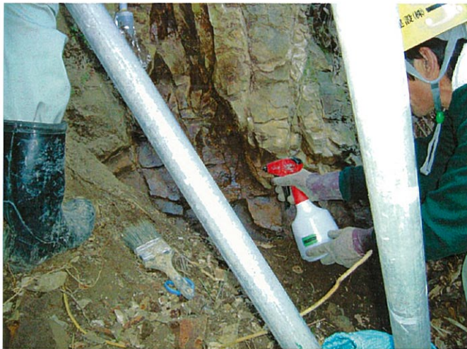
写真 5-5-3 清掃状況（水洗い）
