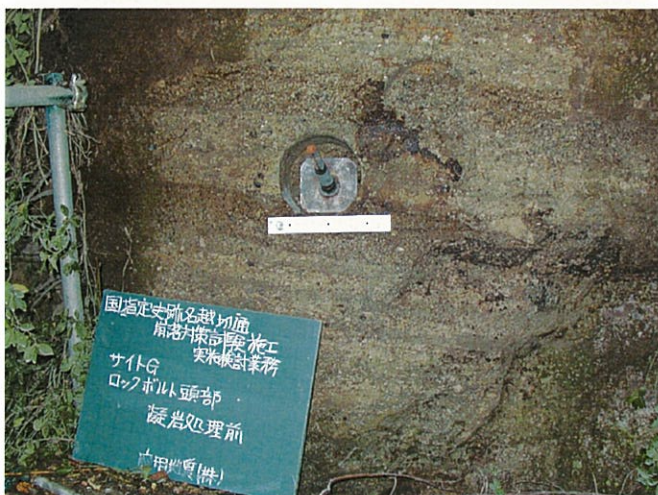
写真 5－3－7（3）ロックボルト引抜試験跡の状況
