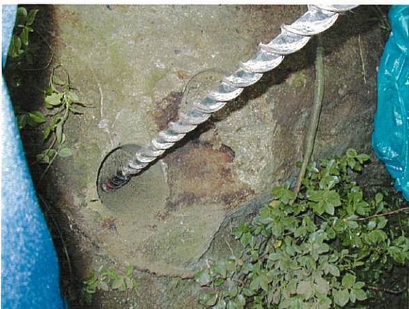
写真 5－3－3 鉄筋挿入のための事前削孔（孔径45mm）
