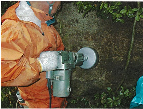
写真 5－3－2 頭部コア抜き（径20cm 深さ20cm）
