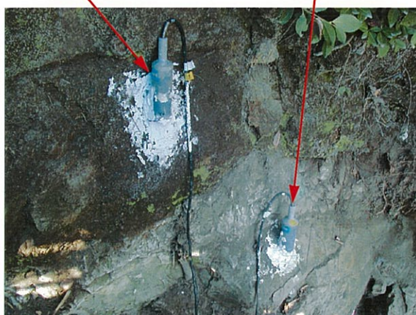
写真 5-5-10 振動計設置状況
