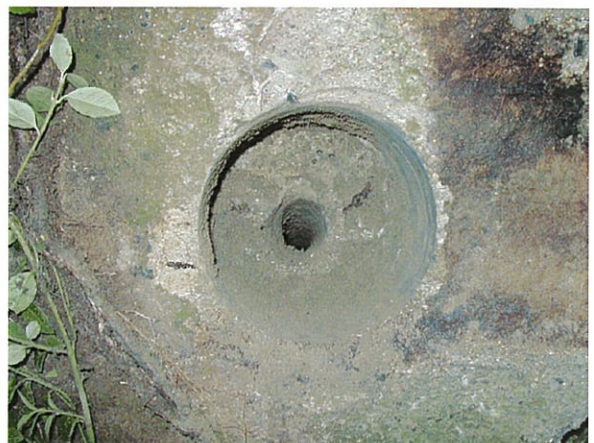
写真 5－3－3 鉄筋挿入のための事前削孔（孔径45mm）
