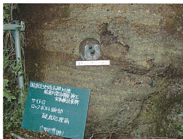
② ロックボルト施工後 ロックボルト打設後の状況（径20cm）
