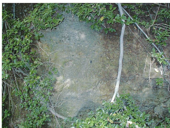
① 施工前 ロックボルト施工前の状況
