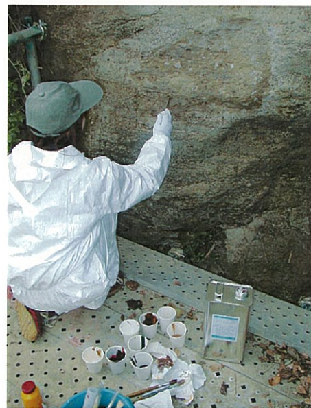
写真 5－3－7（７）擬岩部着色仕上げ処理
