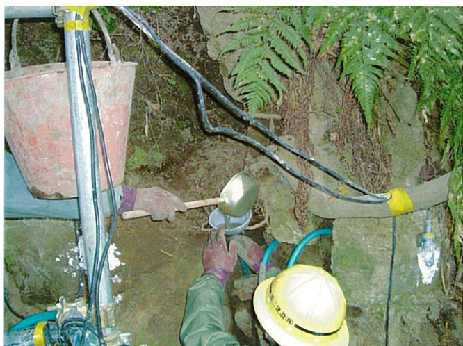
写真 5-5-8 注入モルタル 注入ホースより手作業で注入する。口元 までモルタルが溢れるまで作業を続ける。
