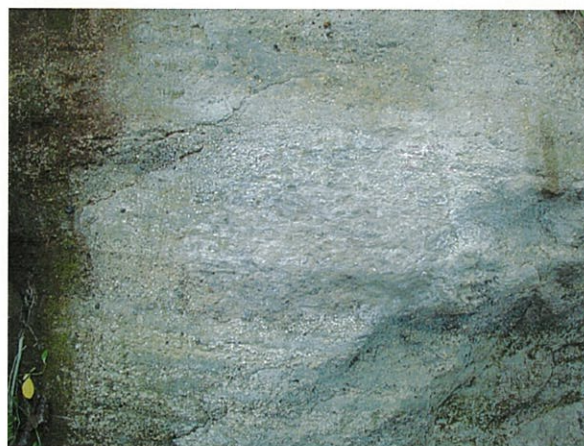
写真 5－3－7（８）擬岩処理完了 岩盤の色彩や地層の様相を再現
