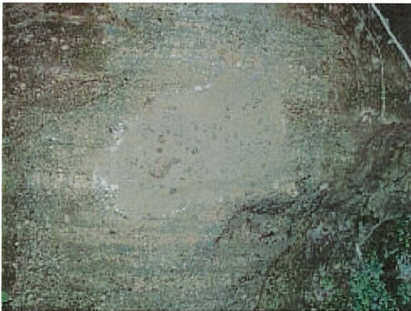
写真 5－3－7（６）擬岩処理状況 全体処理の完了（着色仕上げ処理前）
