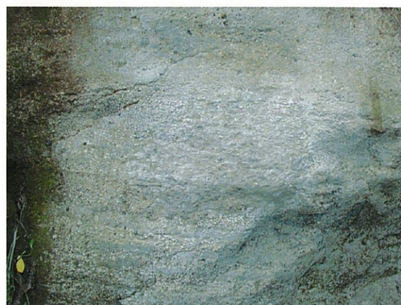
④ 擬岩処理完了（着色処理後） 成形後に着色処理により周辺と調和させる
