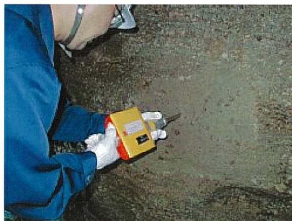
擬岩部でのテスト（1ヶ月養生後）
