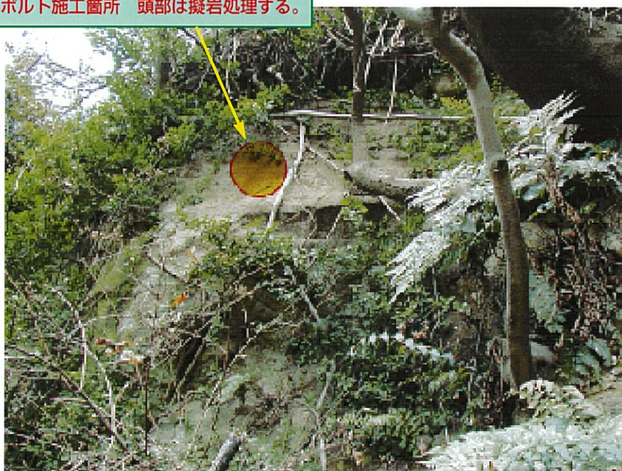
写真 5-3-1 ロックボルト（引き抜き試験）施工箇所
