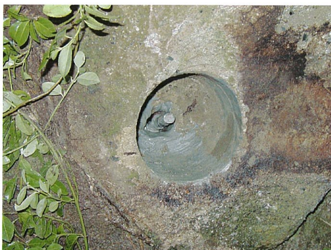
写真 5－3－4, 5 セメントミルク注入、鉄筋挿入後の状況 (鉄筋 ネジテッコン D22 2.0m)
