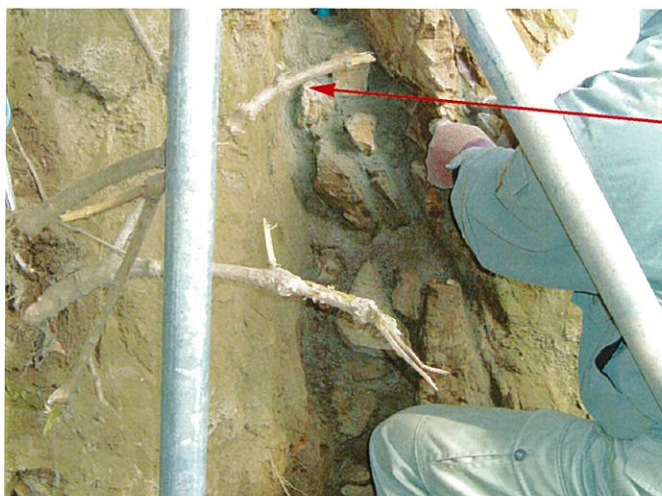
写真 5-5-6 目地立ち上げ状況 DKボンドモルタルと岩片とで割れ目を閉じていく。
