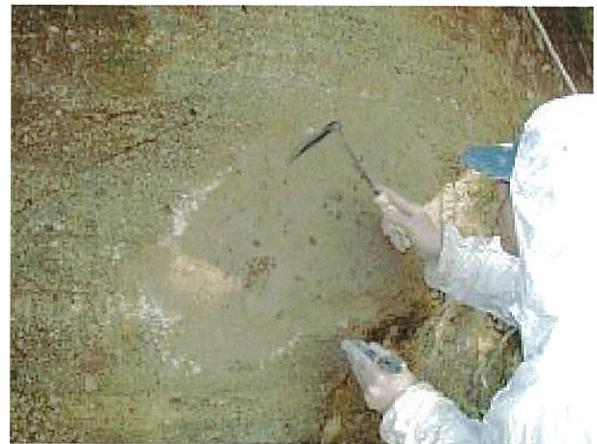
写真 5－3－7（５）擬岩処理状況 成形処理状況
