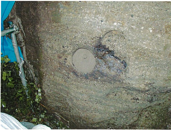
写真 5－3－7（４）擬岩処理状況 ロックボルト頭部箇所の充填
