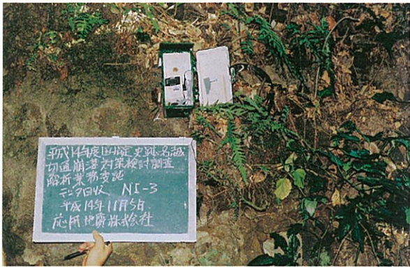
水分計・岩盤温度計 データ回収状況（NI-3）
