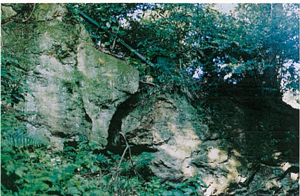
伸縮計 設置状況
