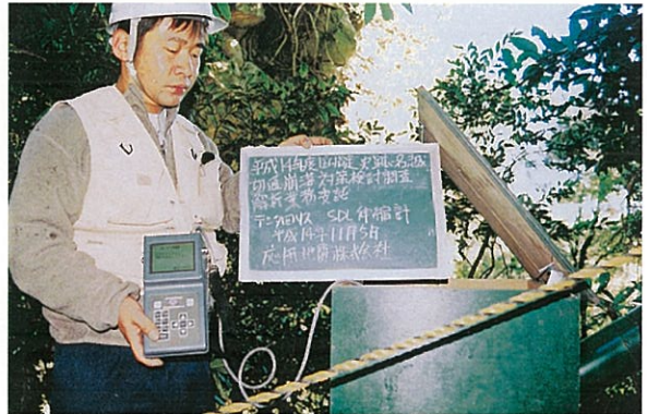
伸縮計 データ回収状況
