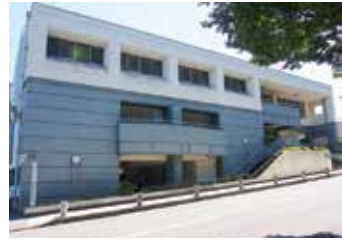
沼間小学校区コミュニティセンター
