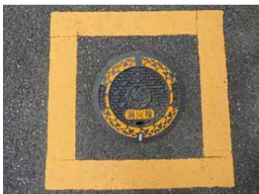
しょうかせん 消火栓
