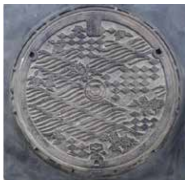
下水道のマンホール
