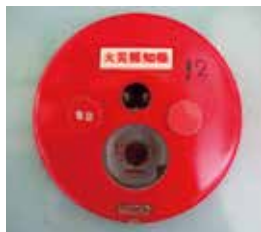
かさいほうちき 火災報知器
