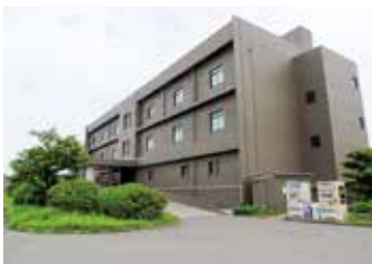
じょうすいかんり 浄水管理センター
