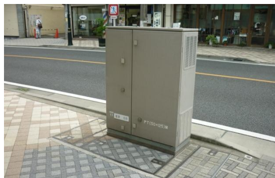
ラッピングする地上機器（変圧器）
