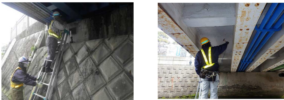
写真5－1 橋りょう点検状況
