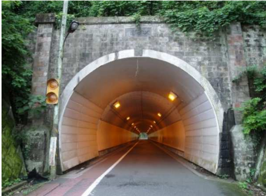
久木トンネル
