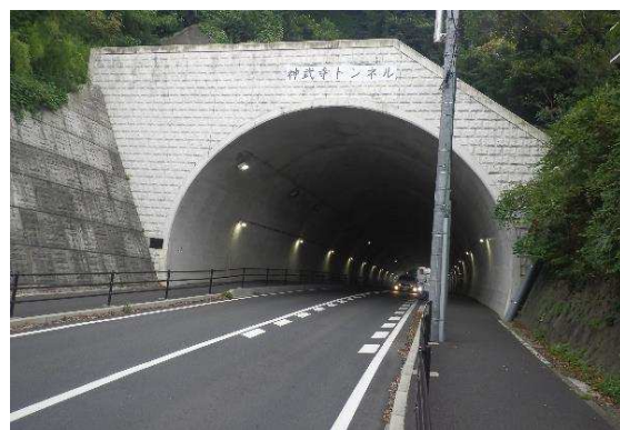
神武寺トンネル
