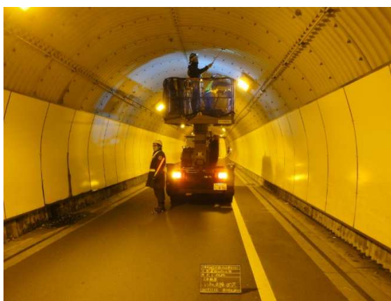
久木トンネルの点検状況
