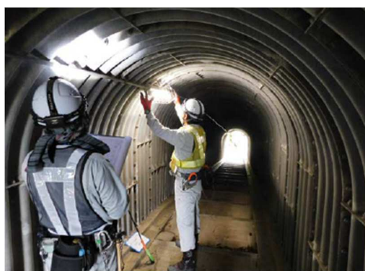
住吉隧道の点検状況
