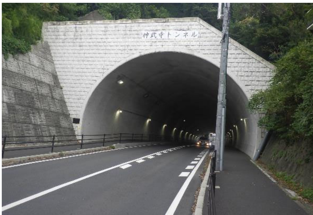
写真：神武寺トンネル
