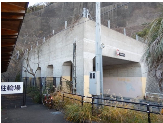
小坪海岸トンネル (ロックシェッド)
