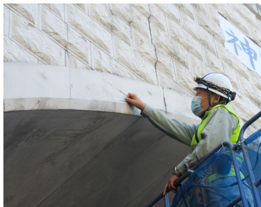
神武寺トンネルの点検状況
