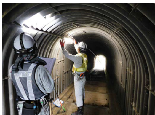
住吉隧道の点検状況
