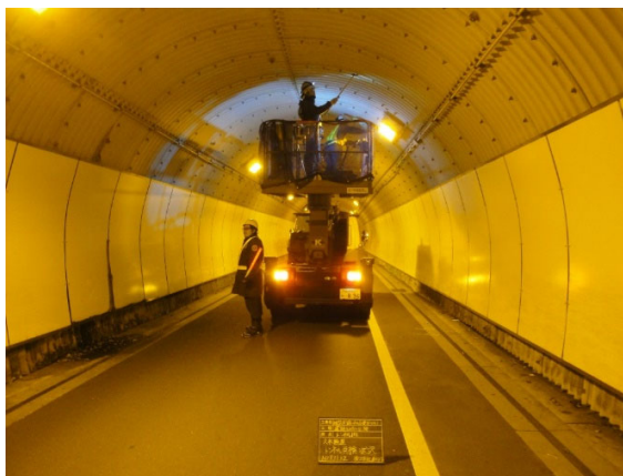
久木トンネルの点検状況
