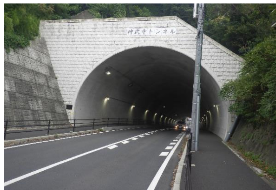
神武寺トンネル
