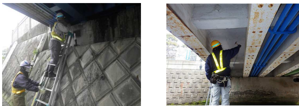
写真5—1 橋りょう点検状況
