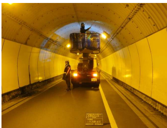
久木トンネルの点検状況
