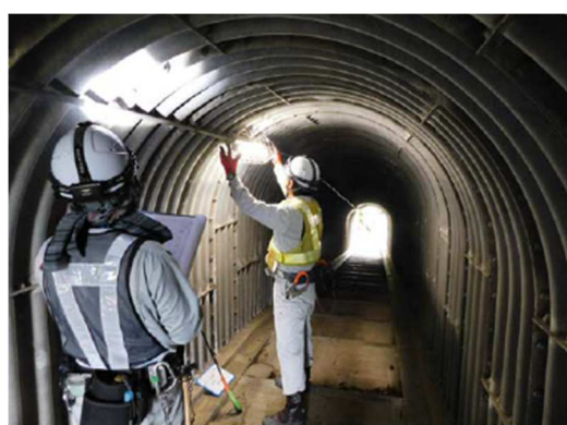
住吉隧道の点検状況
