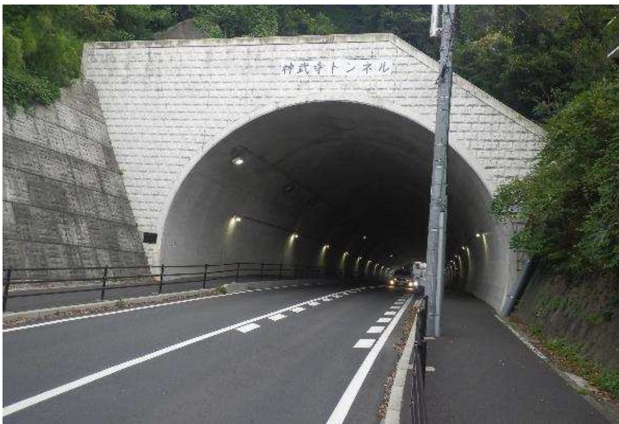
写真：神武寺トンネル
