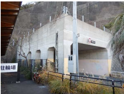
小坪海岸トンネル (ロックシェッド)
