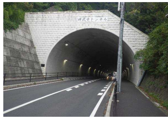
神武寺トンネル
