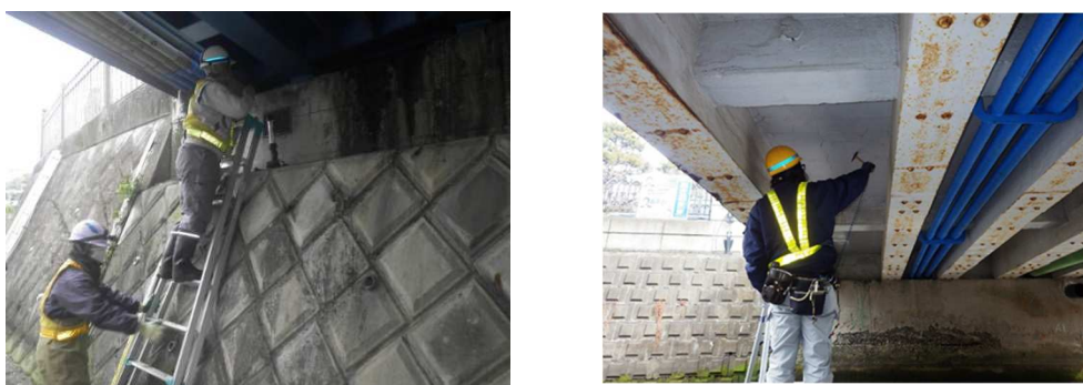
写真6-1 橋りょう点検状況
