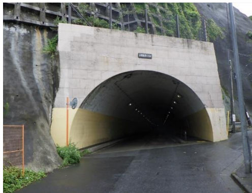
小坪海岸トンネル
