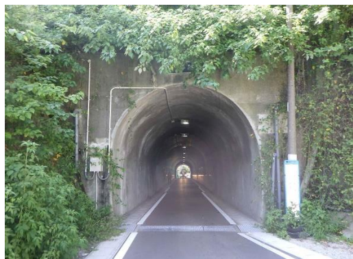
小坪トンネル
