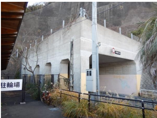
小坪海岸トンネル (ロックシェッド)
