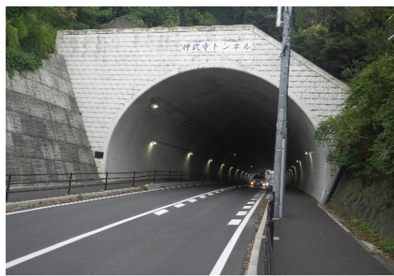
神武寺トンネル
