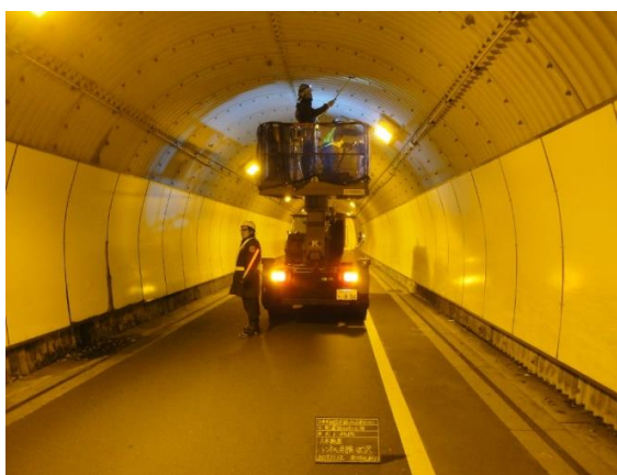
久木トンネルの点検状況
