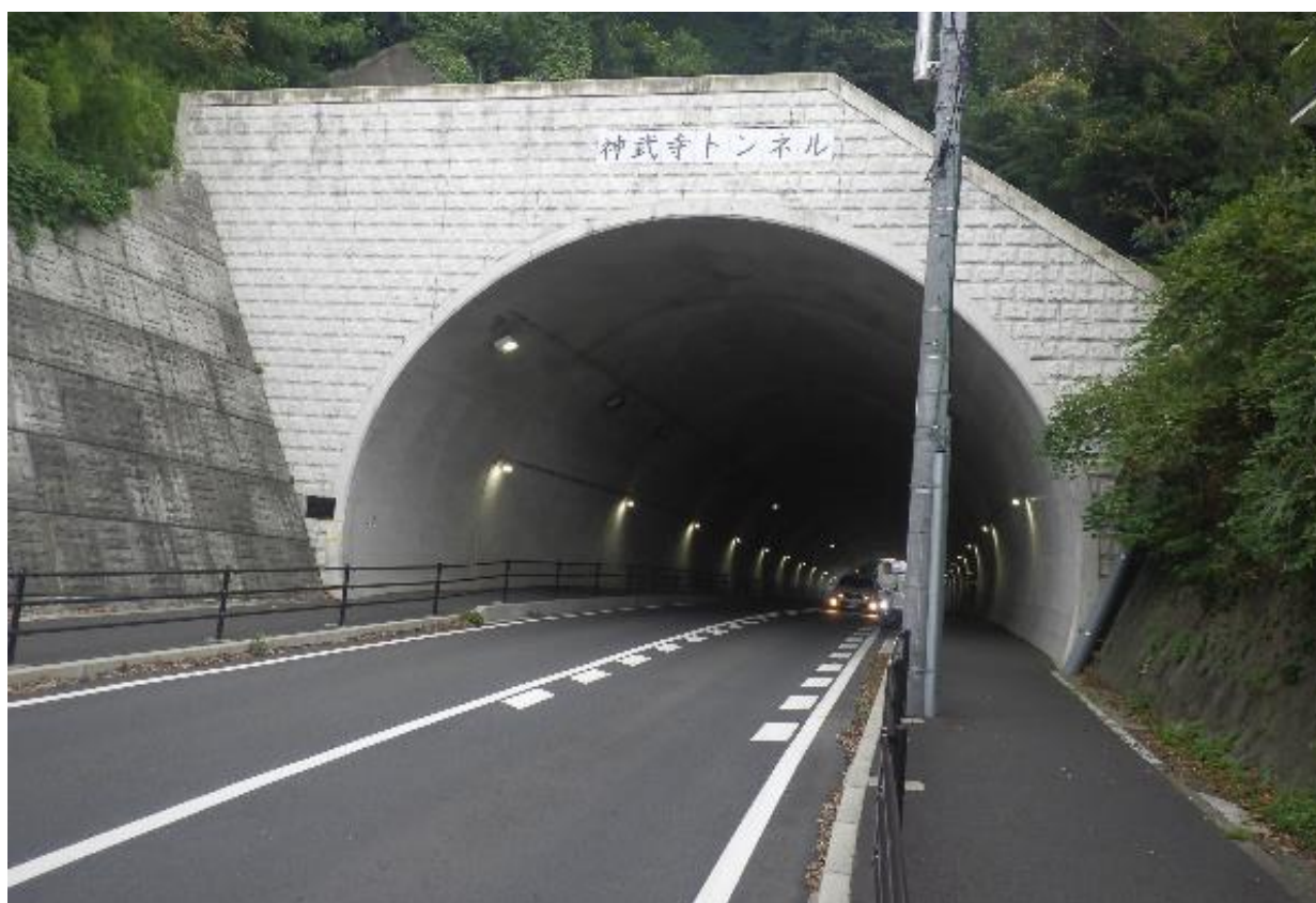
写真：神武寺トンネル
