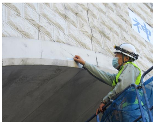
神武寺トンネルの点検状況
