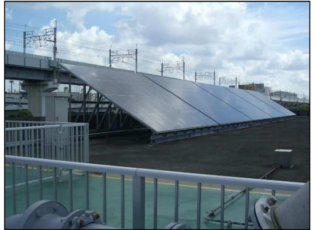
写真 2-7-3-3 水処理施設上部の設置
