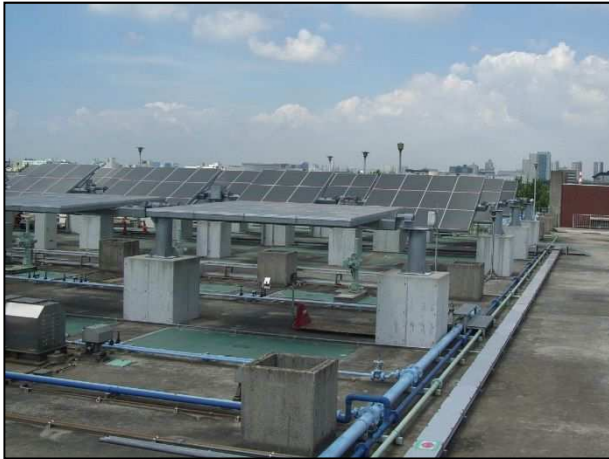
写真 2-7-3-2 水処理施設上部の設置
