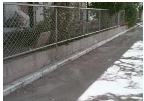
(下水道整備後)
