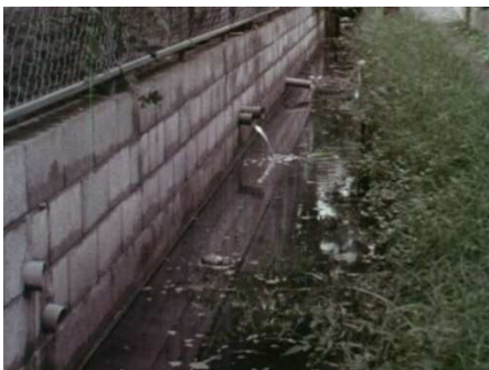
(下水道整備前)
