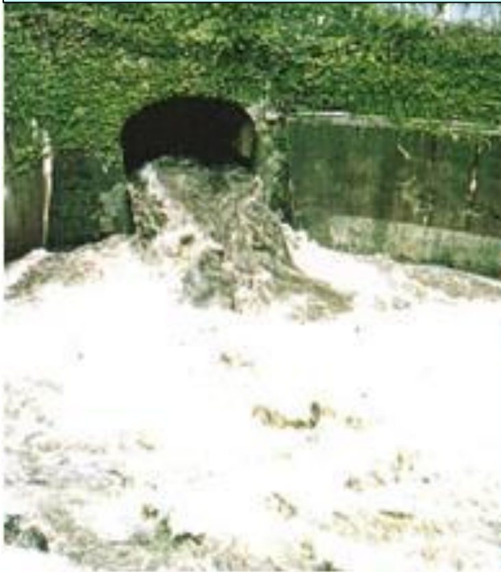
雨水吐き室からの未処理下水の放流
