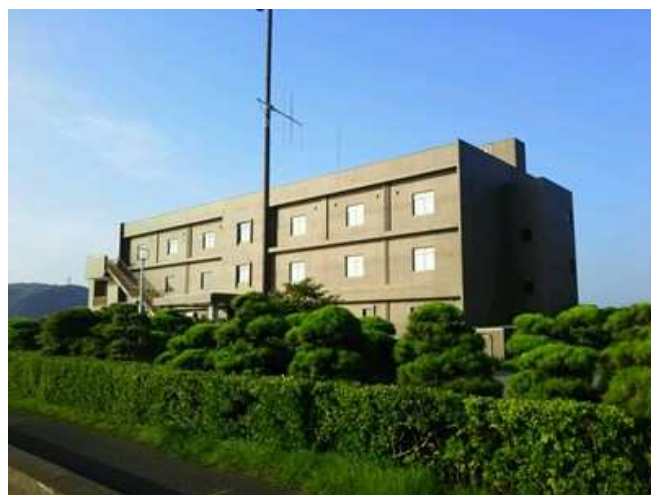
( 逗子市浄水管理センター・管理棟 )
