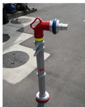
【媒介金具の設置状況】
