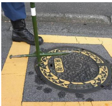
【てこ穴に開閉器を挿入し右に 90 度回転】
