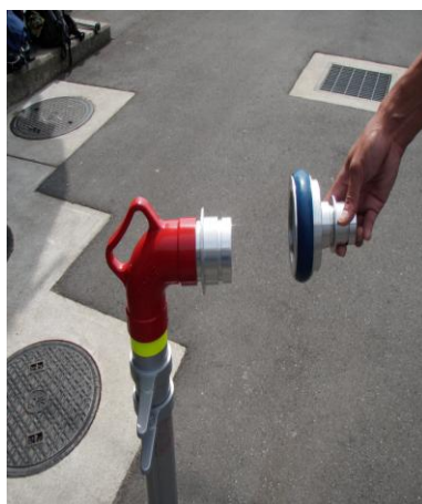
【媒介金具の取り付け】
