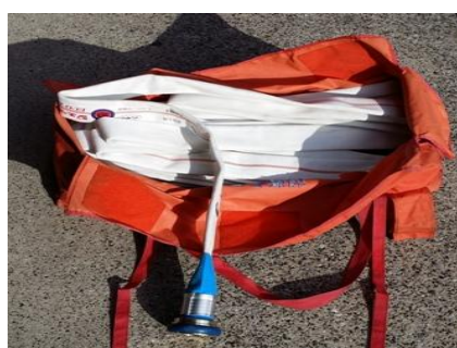
【消防用ホース収納状況】
