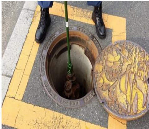
【消火栓開閉器具取付け】
