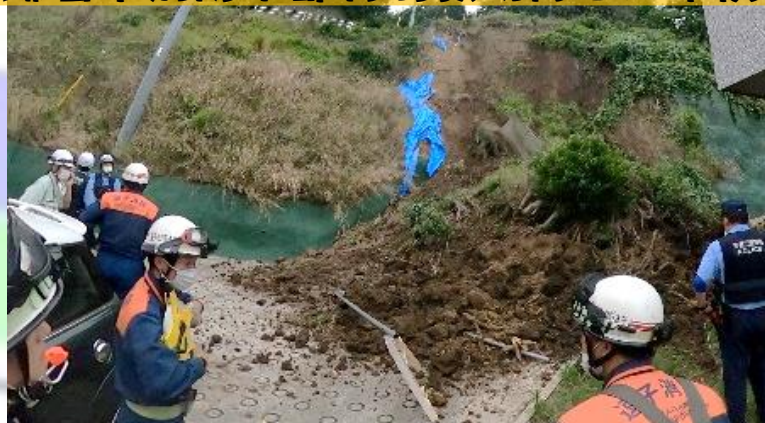
鎌倉市消防本部特別救助隊の地中音響探知機を活用した現場
