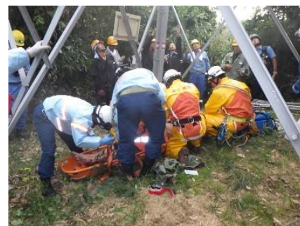
感電事故。作業員が高電圧線に接触して感電。二次災害のおそれがある中、鉄塔上から要救助者を救出した。
