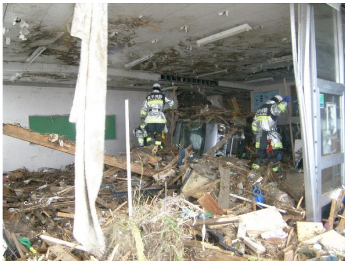
倒壊建物の検索
