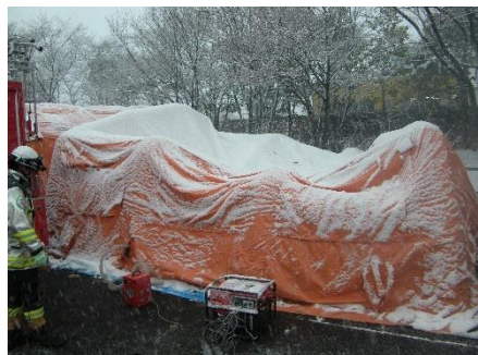
雪の重みで潰れたテント
