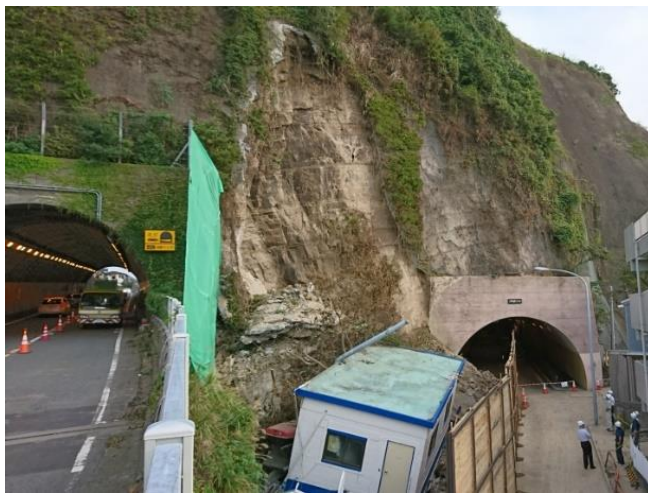
小坪海岸トンネル付近でがけ崩れ
