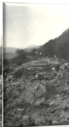
台風による被害状況
