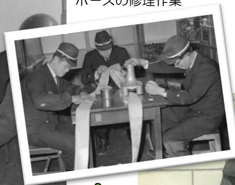
ホースの修理作業
