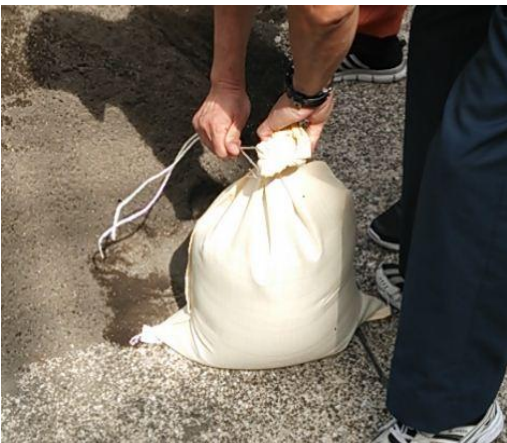
5 ひもを土のう袋に巻きつけながら縛ります。
