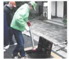
消火栓に差し込む
